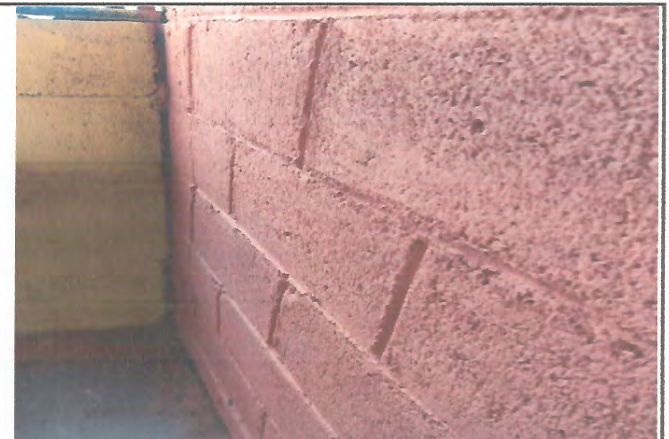
Foto 8: MEJORAMIENTO DE PAREDES
