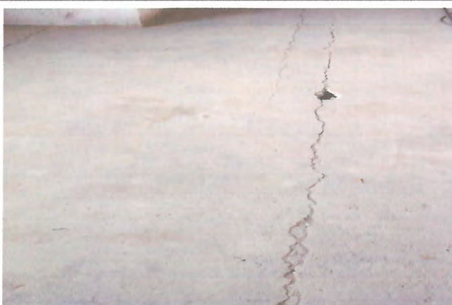
Foto 3: CAMBIO DE PISO DEL AREA DE COCINA
