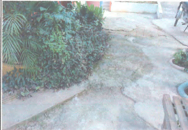
Foto 10: El piso se encuentra con fisura por lo que es necesario el cambio.
