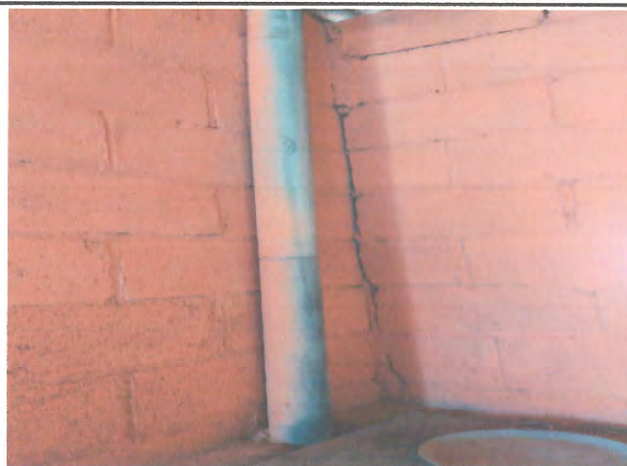
Foto 2: MEJORAMIENTO DE COLUMNAS INTERMEDIAS DEL AREA DE COCINA
