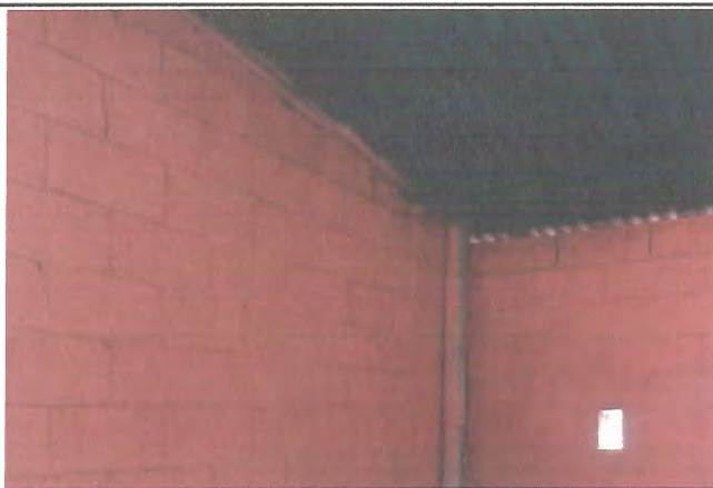
Foto 7: MEJORAMIENTO DEL TECHO DEL AREA DE COCINA
