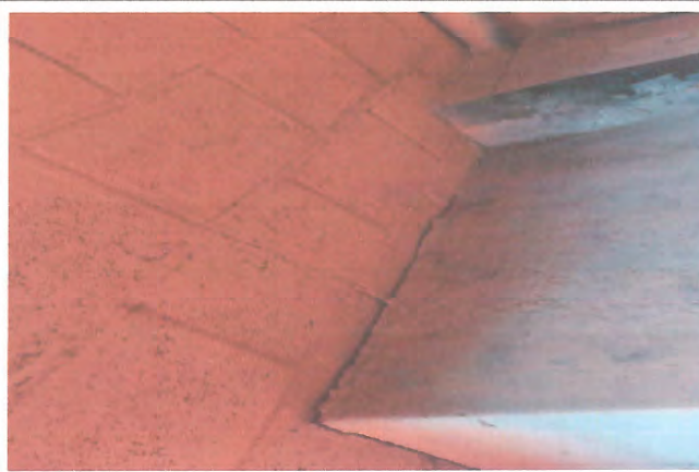
Foto 4: REPARACIÓN DEL POLLETON
